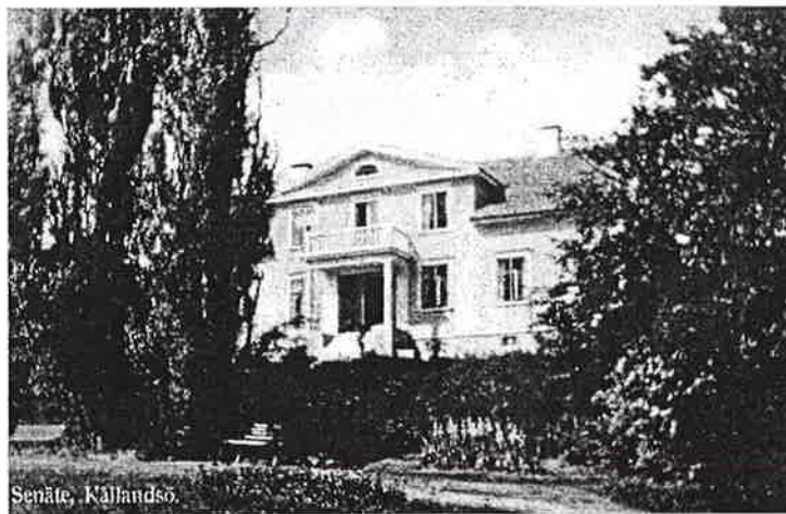
Senäte efter branden på 1920-talet då hela byggnaden återuppfördes.
